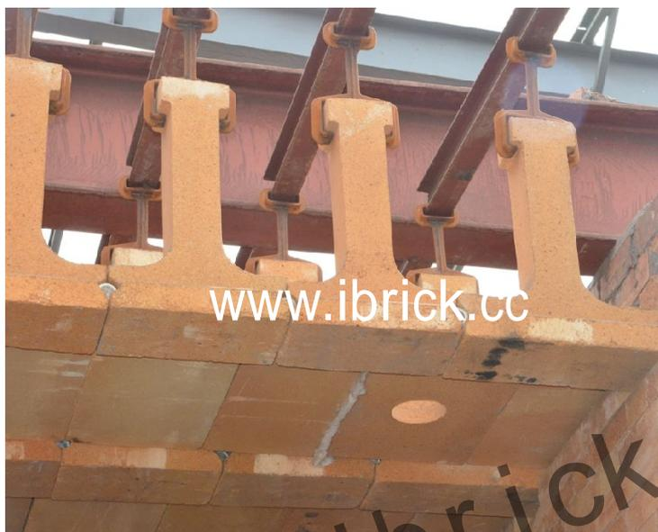
Огнеупорные висячие кирпичи висят на стальных конструктивных вешалках, между огнеупорными и вешалками заполняются огнеупорные материалы, обеспечивая герметичность огнеупорных кирпичей. Огнеупорные висячие кирпичи обеспечивают обычноту ремонта и технического обслуживания.
