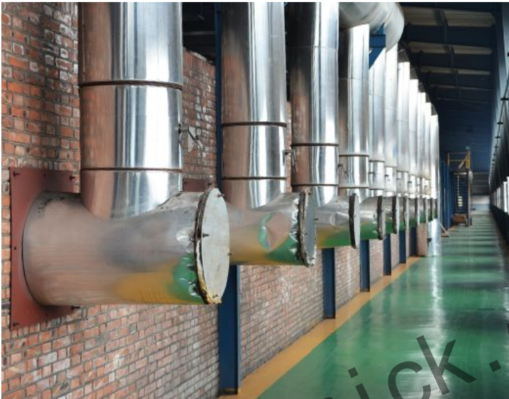
窑体上设有管道，保证了焙烧的氧气给予，烟气的收集以及余热收集。
